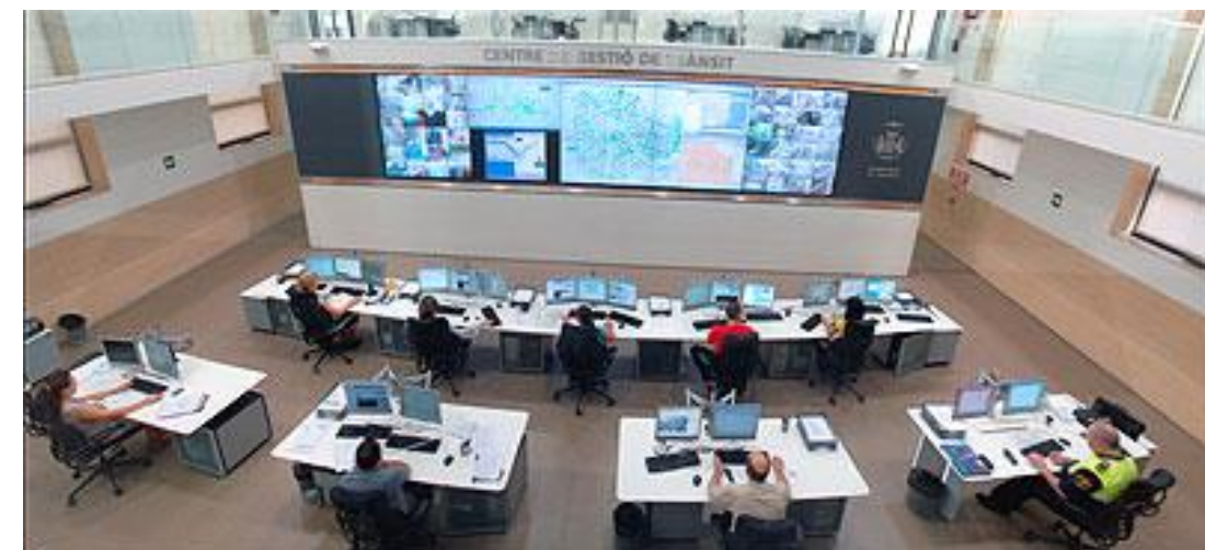
Fig. 184.- Centro de Control de Tráfico de València.
