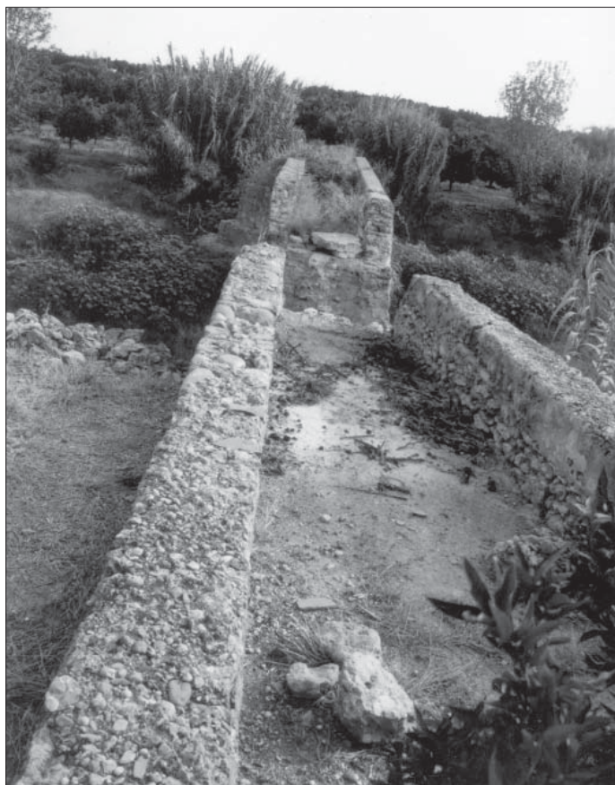
Detall de l'aqüeducte del pont dels Arcs del barranc de Ràtils. Foto de l'autor
