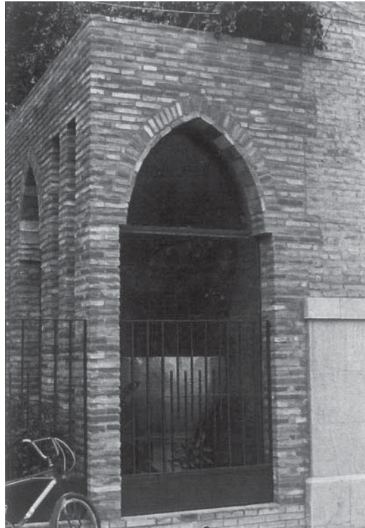
3- Pila gòtica dins del “monument a l’entrada de la Casa Abadia de la Parròquia de les Alqueries (Foto Antonio, Alqueries 1981)
