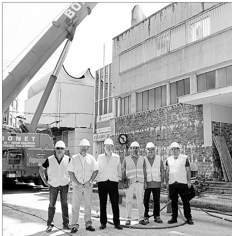
El concejal Emilio M. Obiol, supervisando las obras de demolición.
