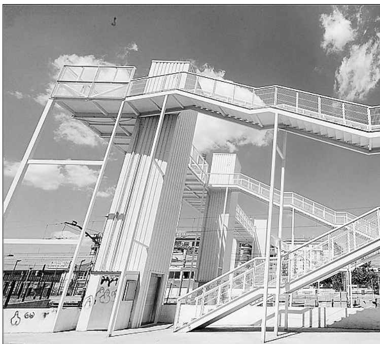
Los ascensores de la plataforma han generado numerosas quejas.
