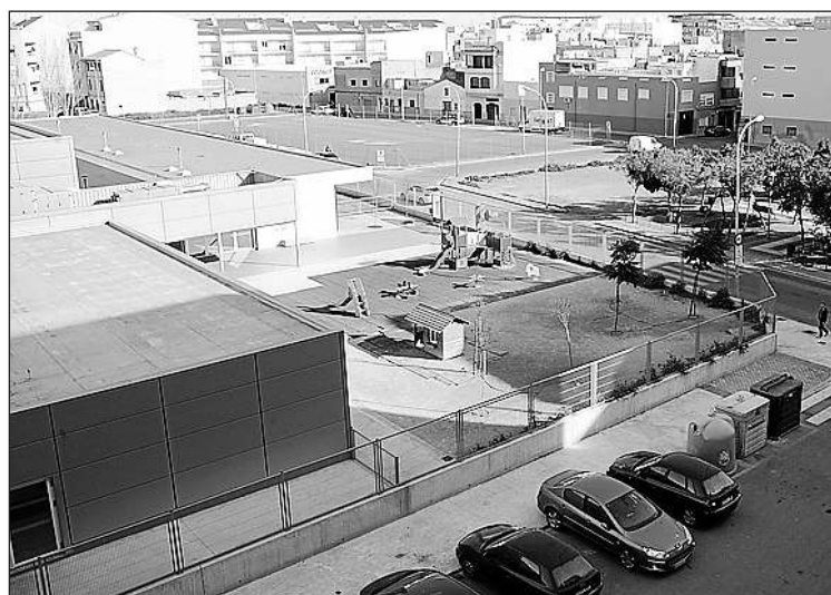
No és la primera sentència referent a la construcció del centre.
