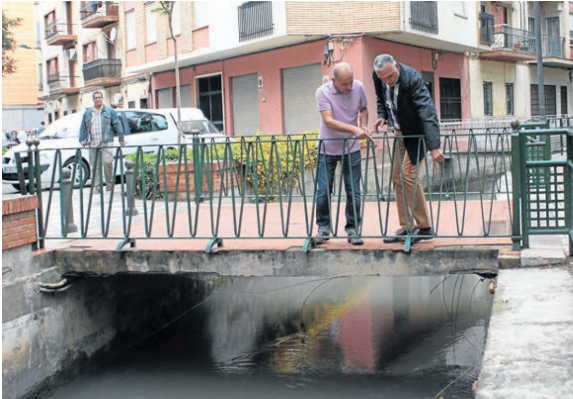
El puente para salvar la acequia presenta algunos desperfectos aunque no supone un riesgo para la seguridad.
