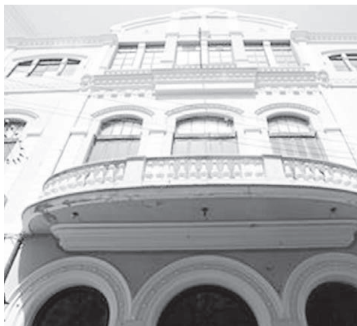
Este edificio tiene peculiaridades como la fachada de azulejería modernista.
