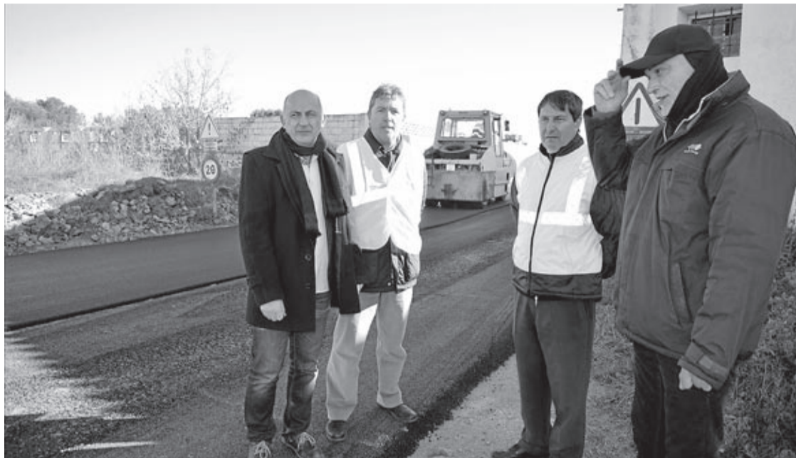
El regidor Valverde va visitar un dels trams que s'ha asfaltat, el camí de Vora Riu, per a conèixer l'estat dels treballs.
