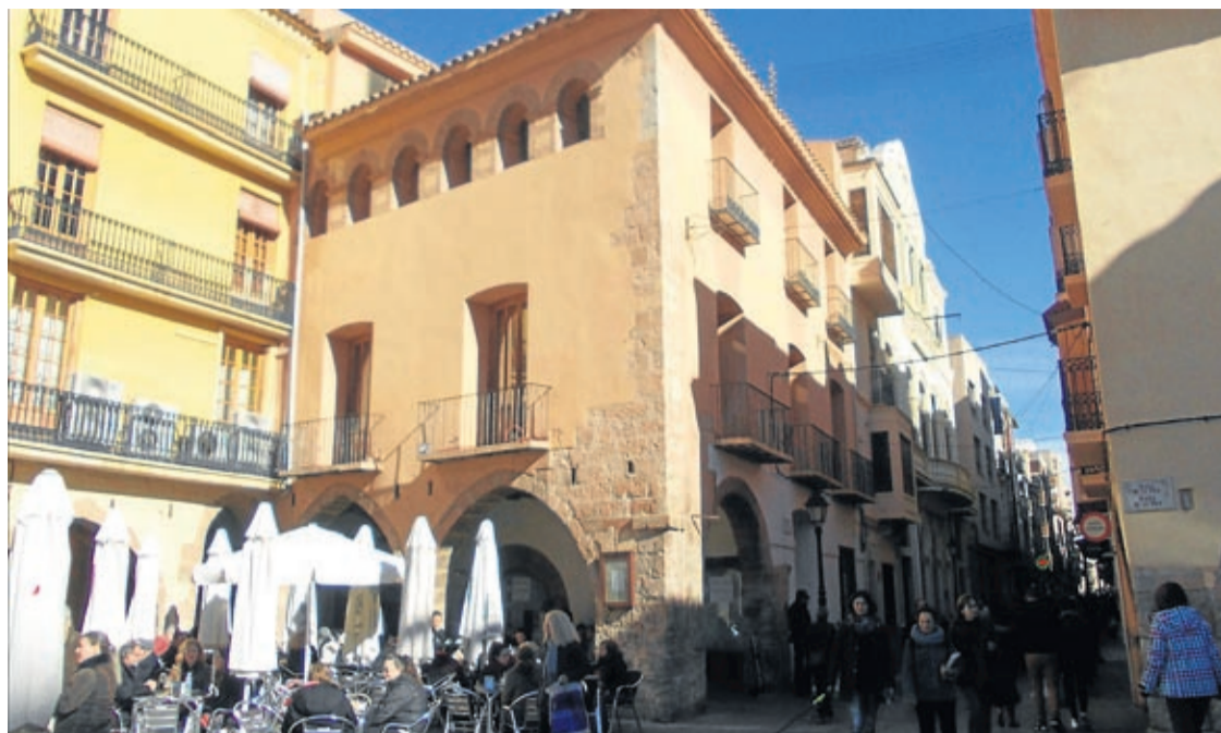
Este edificio, ubicado en la plaza de la Vila, está protegido por el PGOU y no ha sido antes de titularidad municipal.
