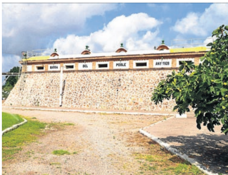
Panorámica de la instalación de la Bassa del Poble de Vila-real.
