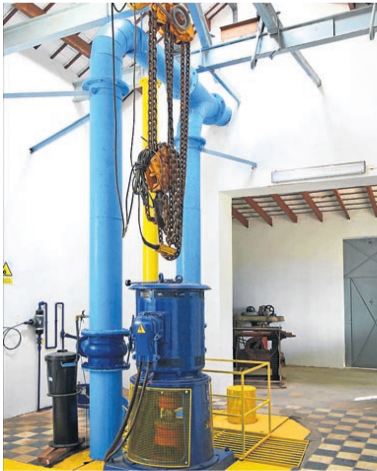
Detalle de la bomba vertical que funciona en la Bassa del Poble.
