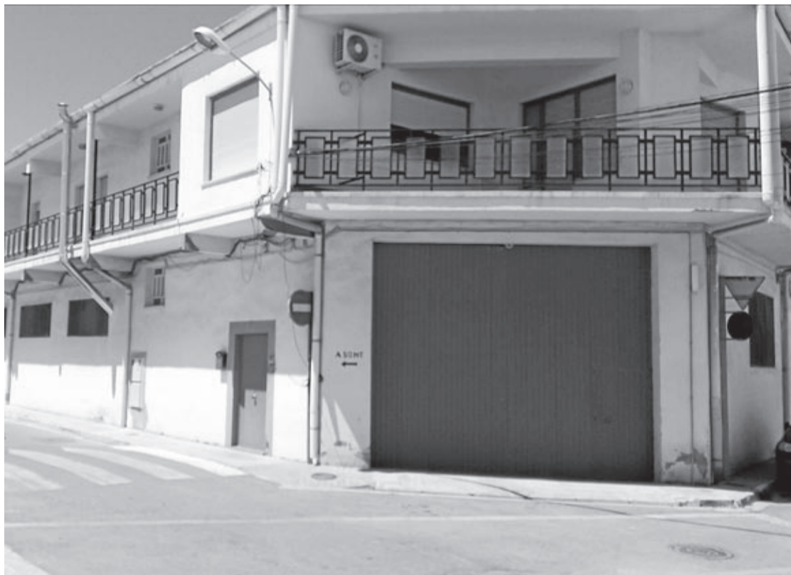
El estado del inmueble, en situación de «peligrosidad y ruina», motivó a Cáritas a desplazar sus servicios a otros recursos.
