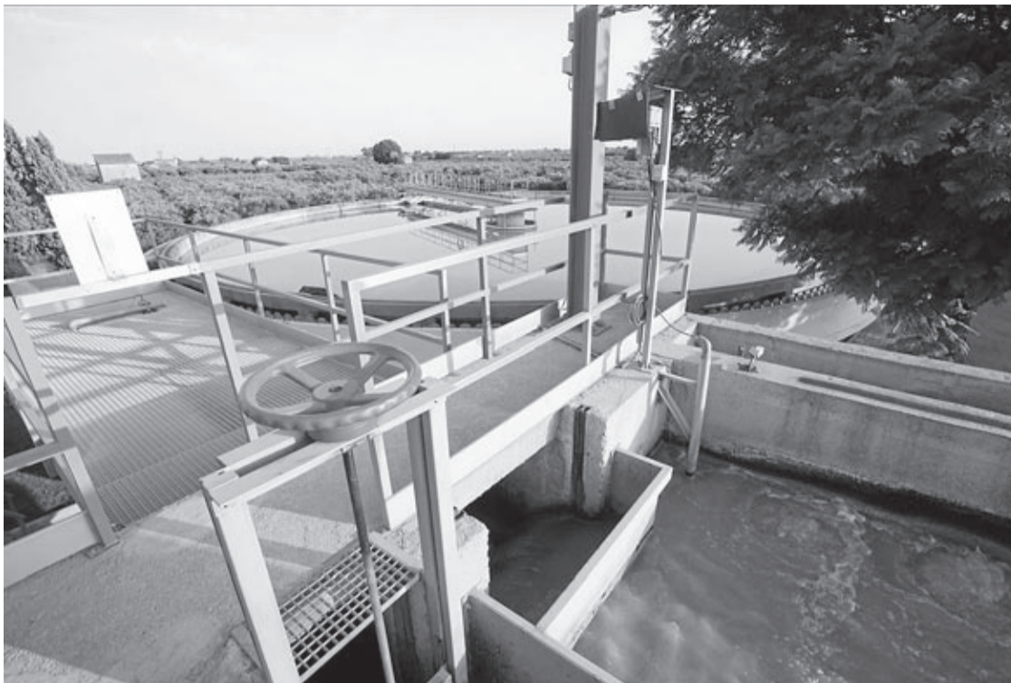
Esta actuación permitirá acabar con los problemas ambientales que genera la depuración de aguas de la ciudad.
