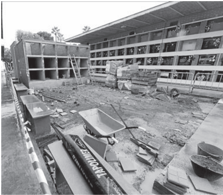
La construcción de nuevos nichos y columbarios ya se están ejecutando.
