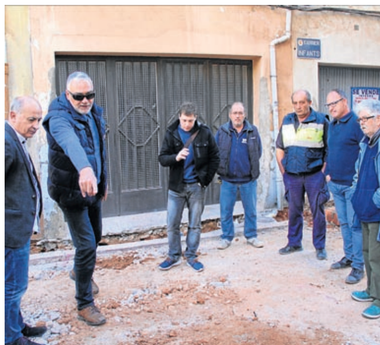
Valverde conversó con los vecinos de la zona durante la ejecución de la obra.
