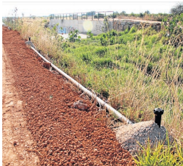
Los trabajos, que sufragará la Generalitat, subsanan errores del proyecto inicial.
