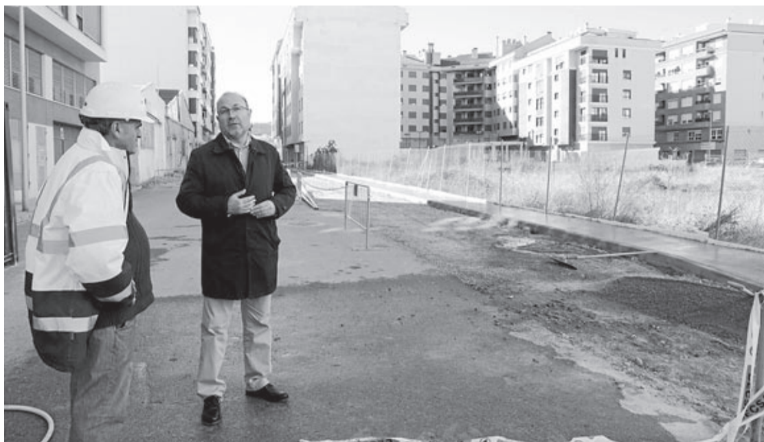
Obiol visitó el estado de los trabajos que suponen una actuación integral de pavimentación de ambos viales.
