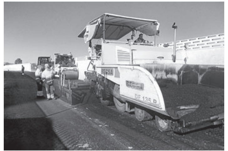
Les actuacions afectaran 5,6 quilòmetres de vies de zones rurals.
