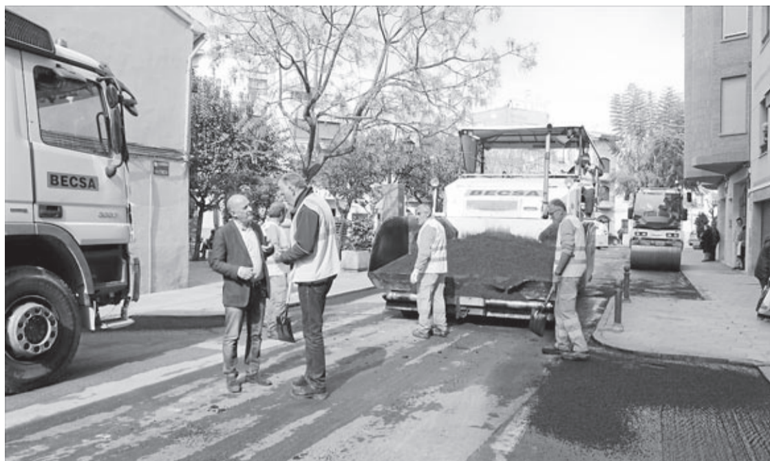
Valverde visitó las actuaciones de urgencia en la calle Valencia para reparar el firme y ganar en accesibilidad.
