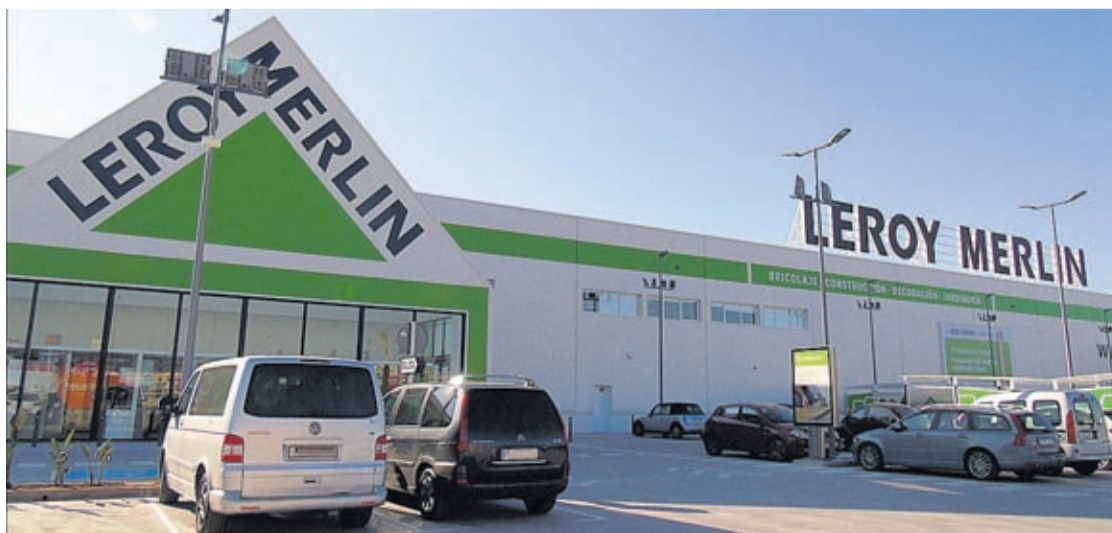
La nueva infraestructura de la empresa de bricolaje cuenta con una superficie de 12.000m 2 entre tienda y almacén.
