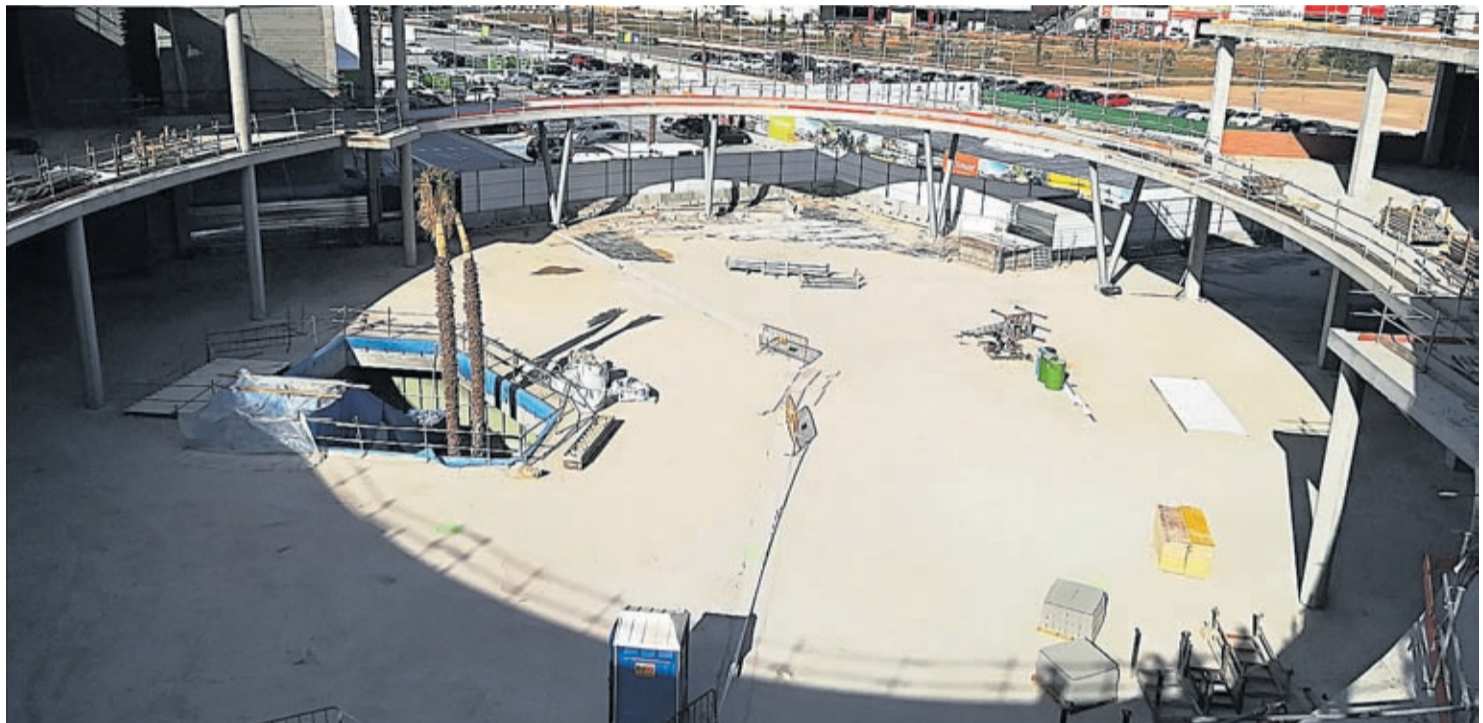
Becsa continúa trabajando en la construcción de la tercera fase, que se prevé concluir tras el verano, para completar este centro de ocio de la capital.
