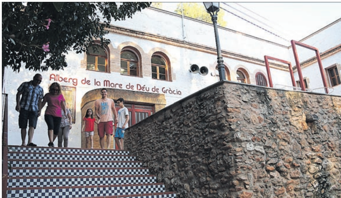
El projecte preveu la remodelació i millora integral de l'edifici situat al paratge del Termet de la Mare de Déu de Gràcia.
