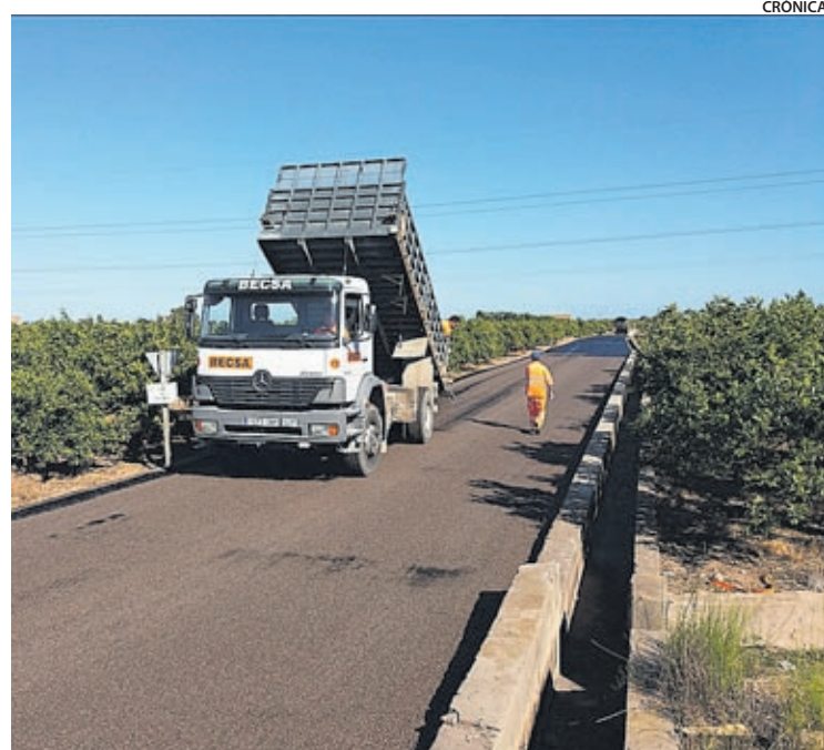
Los trabajos de reasfaltado se acometen acorde al nivel de prioridad de la vía.
