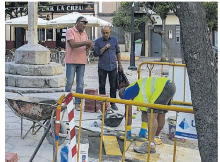
La obra permite hacer accesible la plaza desde las calles que la bordean.
