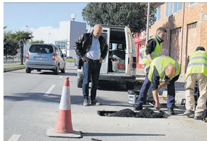
Valverde comprueba la colocación del nuevo material asfáltico en una calle,
