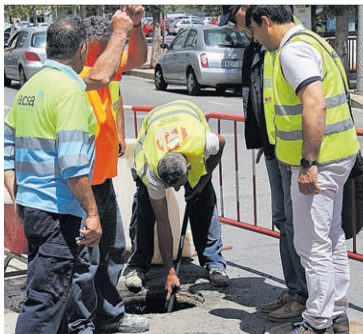
En verano hubo problemas que obligaron a revisar algunas alcantarillas.
