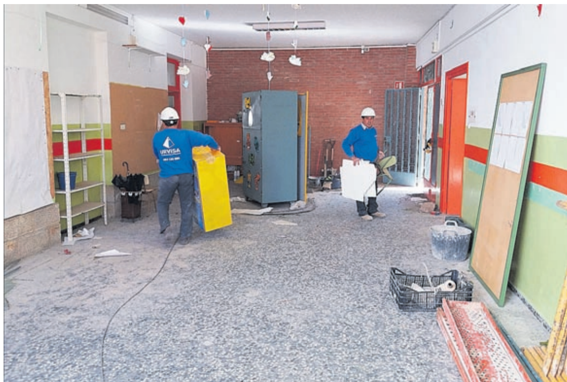
Con los trabajos, se habilitarán las dependencias interiores para oficinas y despachos y también para almacenes.
