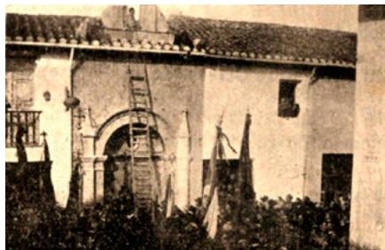
▲ Demolició de l'antiga capella de la Mare de Déu dels Àngels
