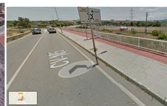
Izqda.- Paso elevado CV185 sobre N-340. Dcha Sección paso elevado CV185 con insuficiente carril bici
