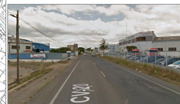
Vista del estado actual de la Ctra Vila-real Onda.
