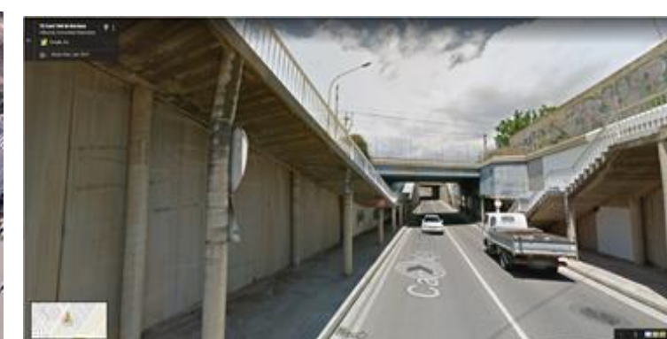
Paso Peatonal inferior camí Vell de Borriana.
