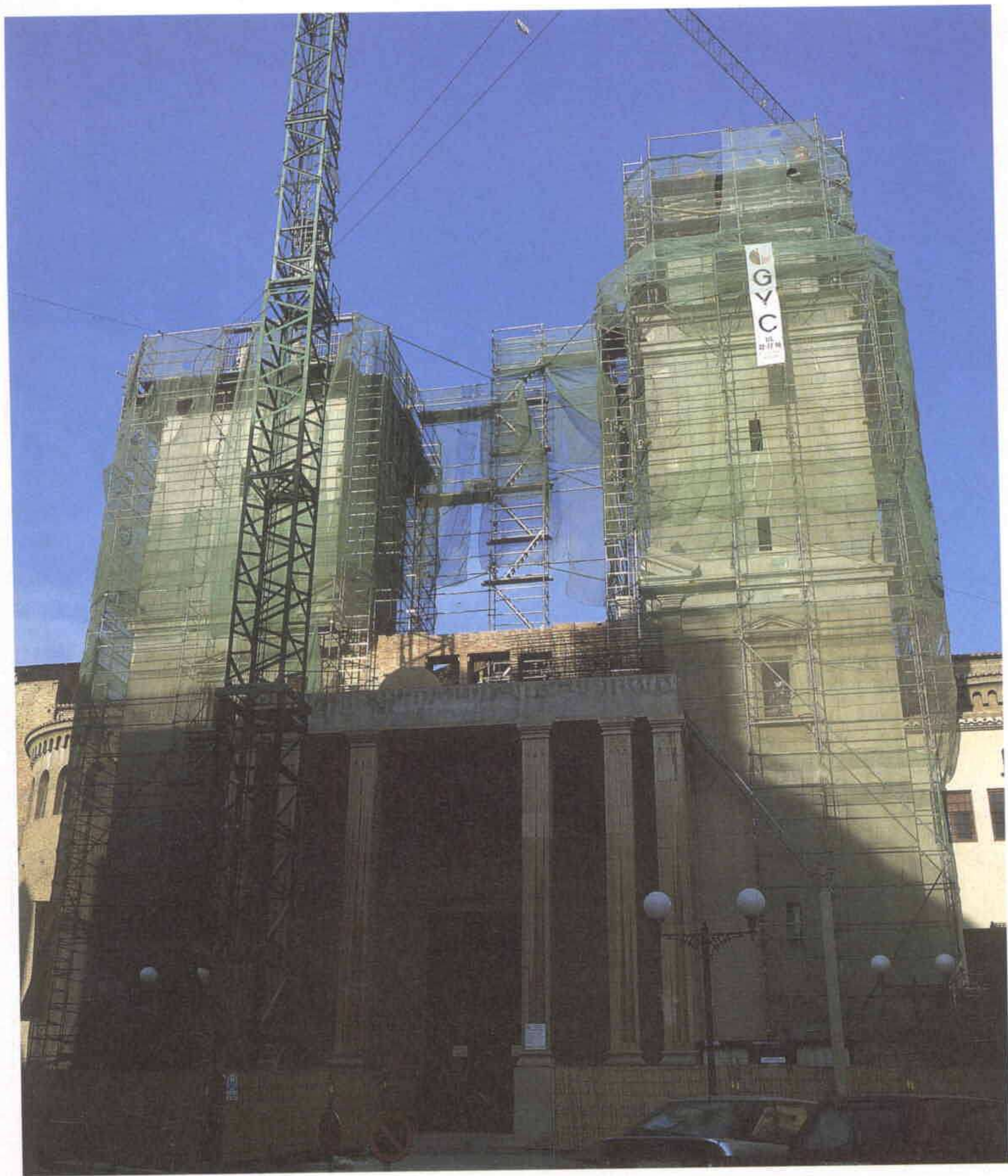
BASÍLICA DE SAN PASCUAL Fachada principal en construcción
