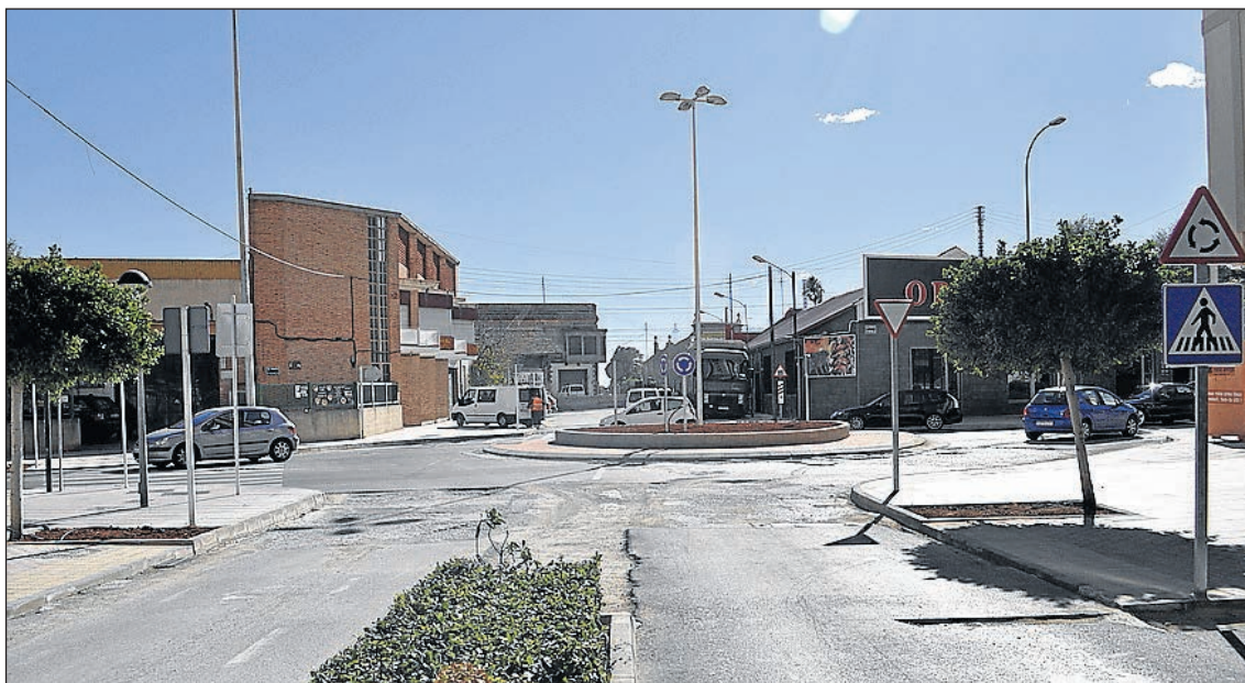
El cruce de la avenida del Cedre con la de Francia ya cuenta con una rotonda para regular el tráfico.
