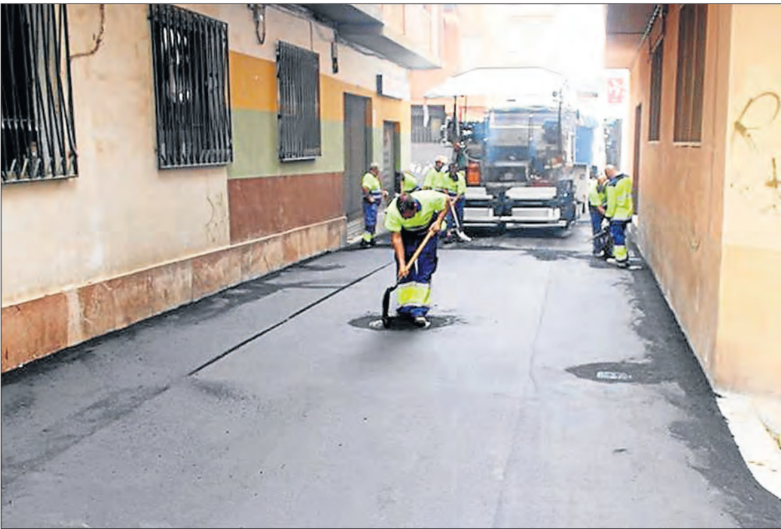
La remodelación de la calle El Tancat es una de las mejoras que ha llevado a cabo Servicios Públicos.
