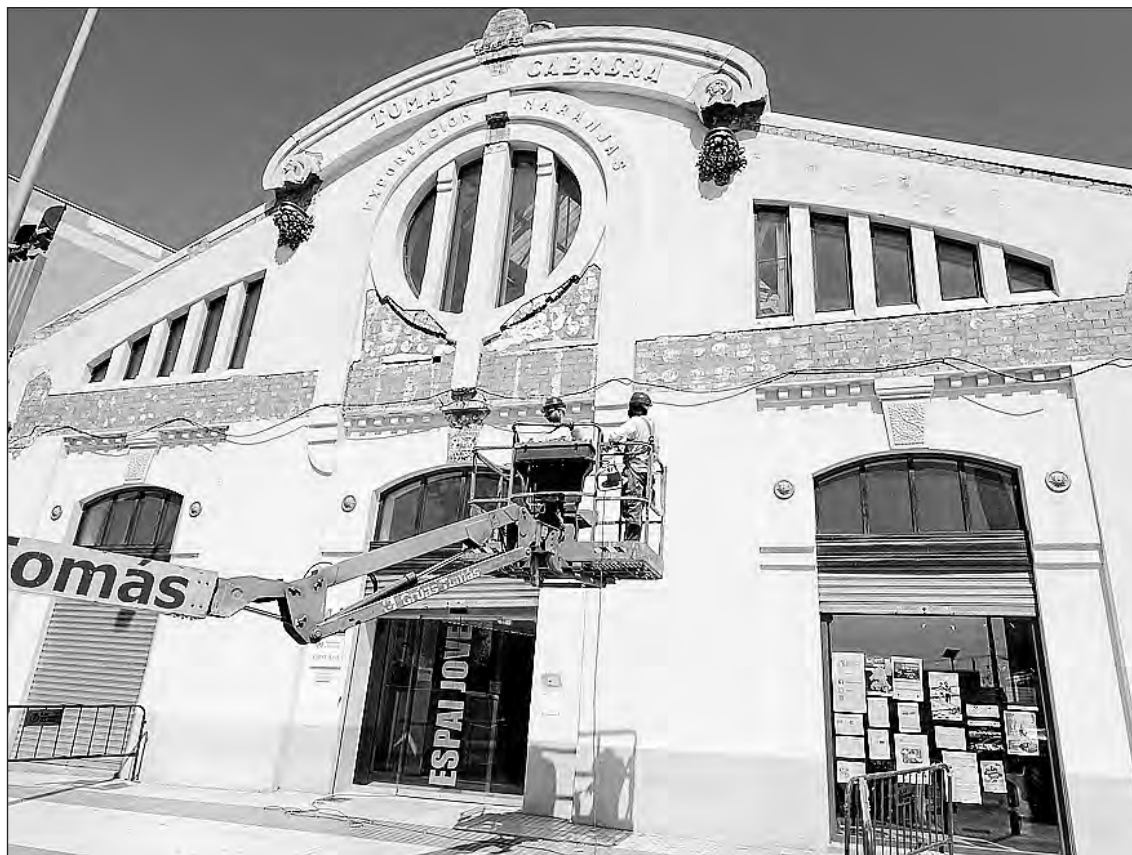
Imatge de l'inici de les obres, al mes de juny, amb els tècnics muntant les noves peces a la façana.
