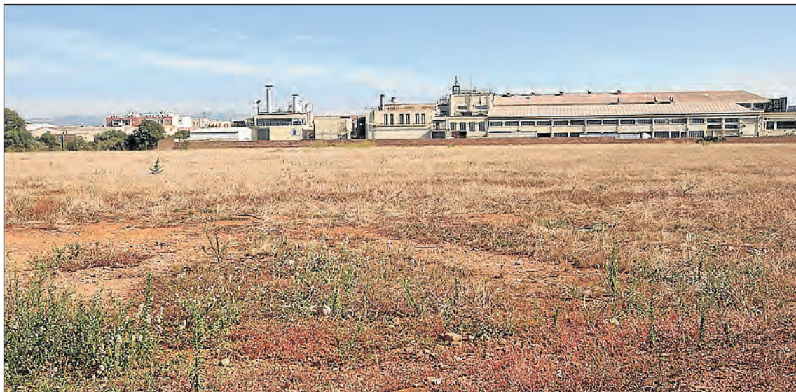
Les màquines començaran a treballar als terrenys de la Bassa d'Insa previsiblement al mes de novembre.
