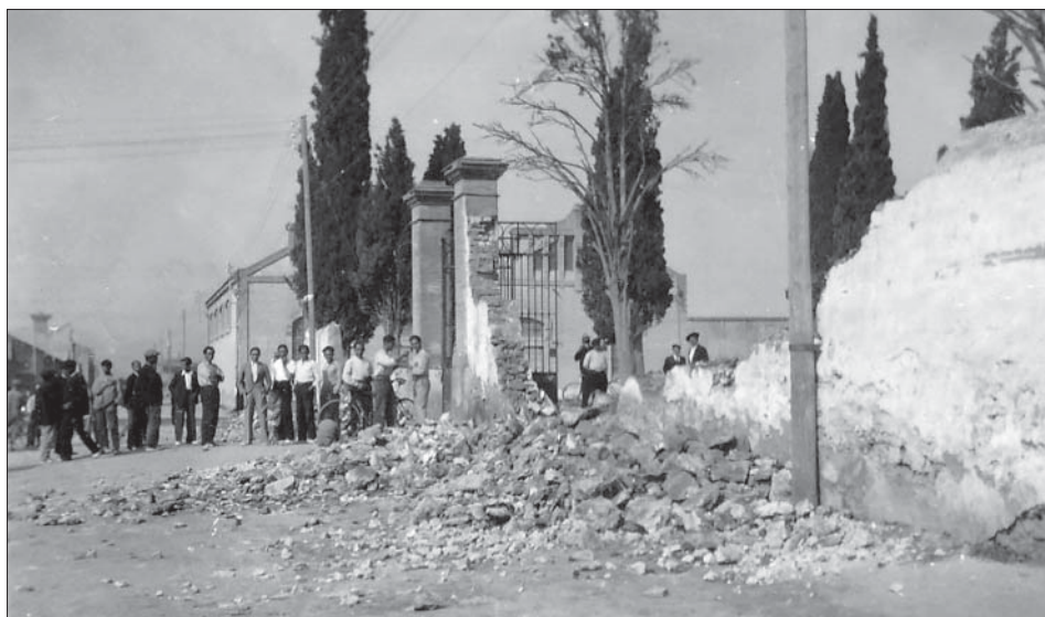
Calvari, enderrocament del mur, 1 de maig de 1931
