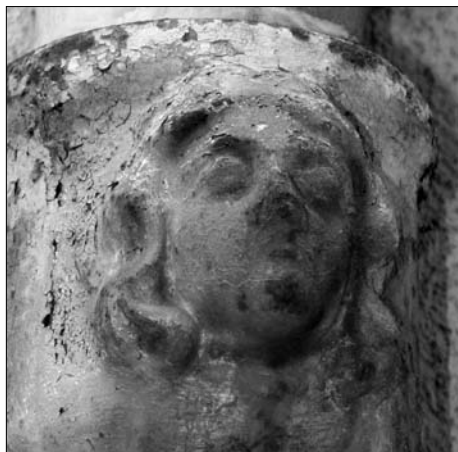
Canalera del carrer de Sant Miquel
