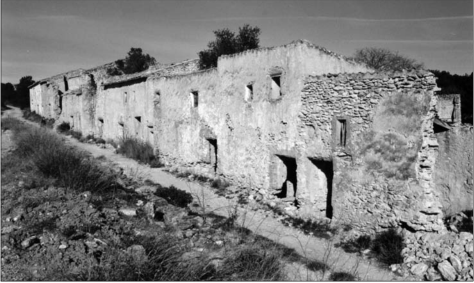
Les Casetes en l'estat actual. Foto de l'autor
