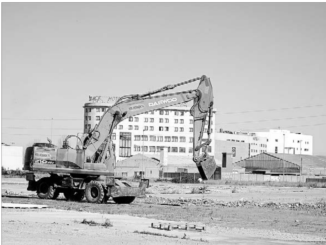
Terreno de la antigua fábrica de Fritta, que adquirió una inmobiliaria asociada al Santander para pisos.
