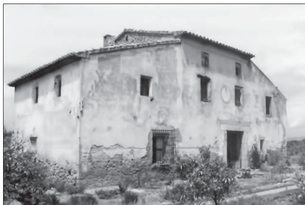
Façana principal de l'arquitectura. Sobre la llinda de la porta d'accés principal està gravada la data de construcció: 1729
