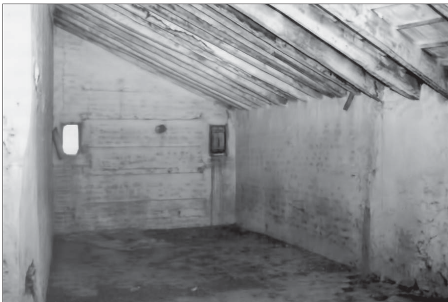
Cambra utilitzada com a graner, en el primer pis. Els murs són de tapial valencià i el paviment de rajola
