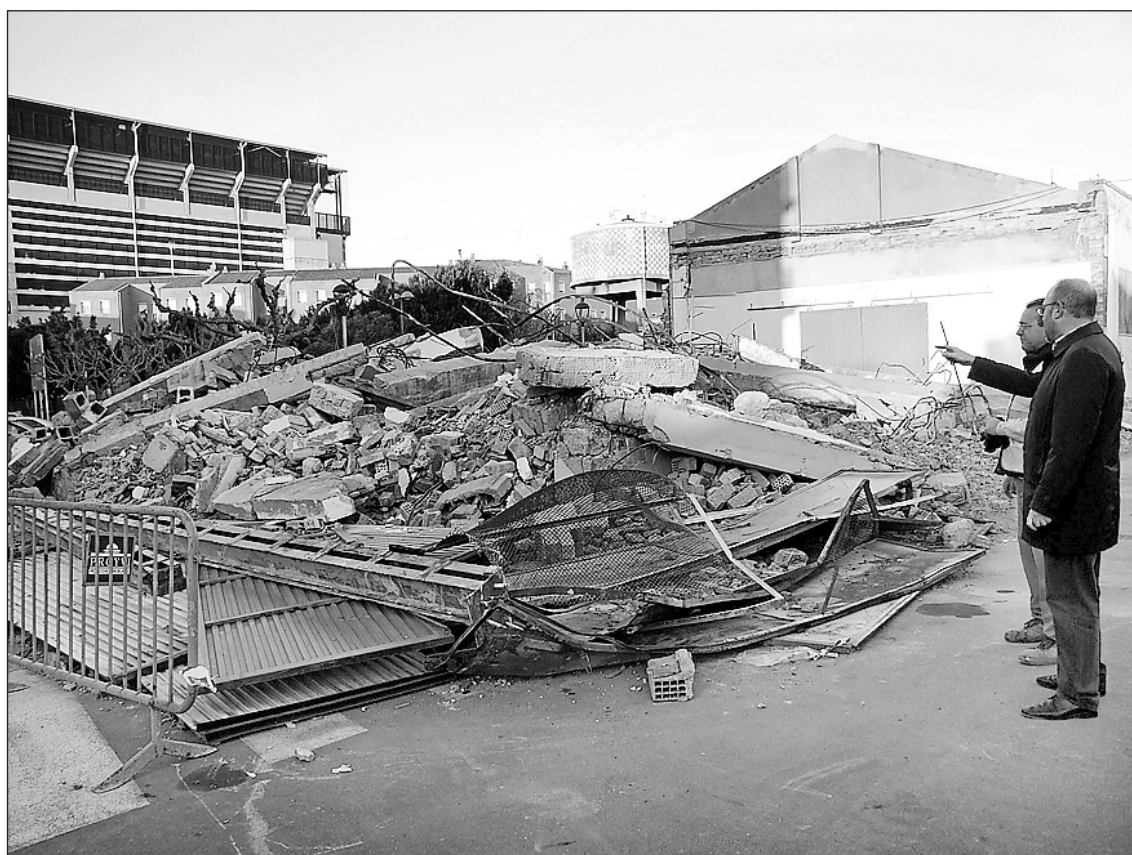
El regidor de Territori ha visitat les obres de demolició de part de la casa de barri de la Sénia.
