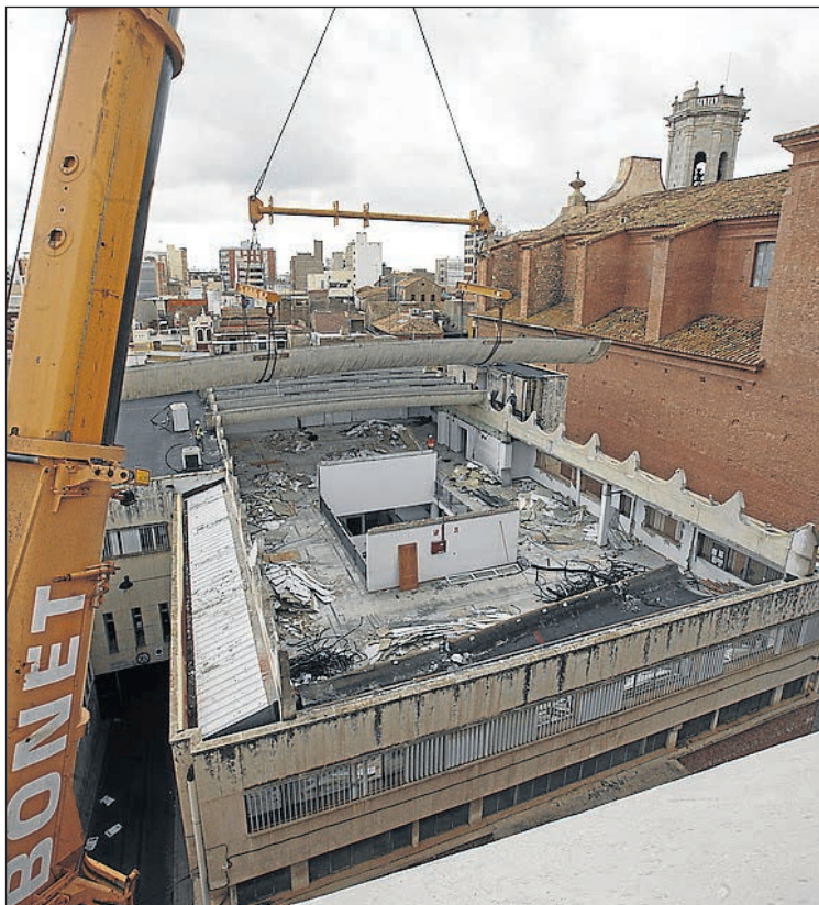
Imatge de l'enderrocament de l'edifici dels antics jutjats al centre.
