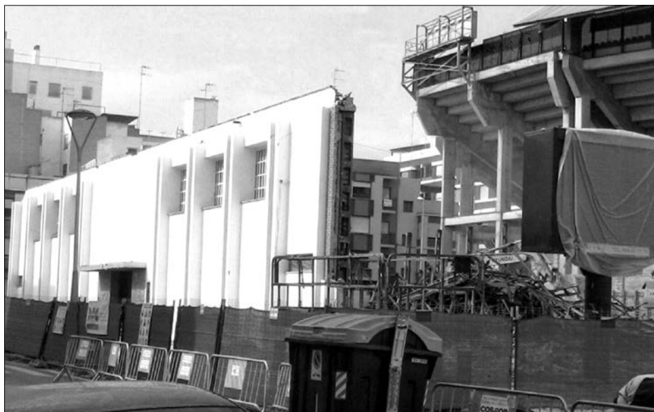
Enderrocament del pavelló del Campió Llorens
