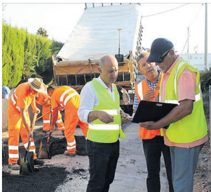
Valverde visitó las obras de rebacheo iniciadas a finales de julio.
