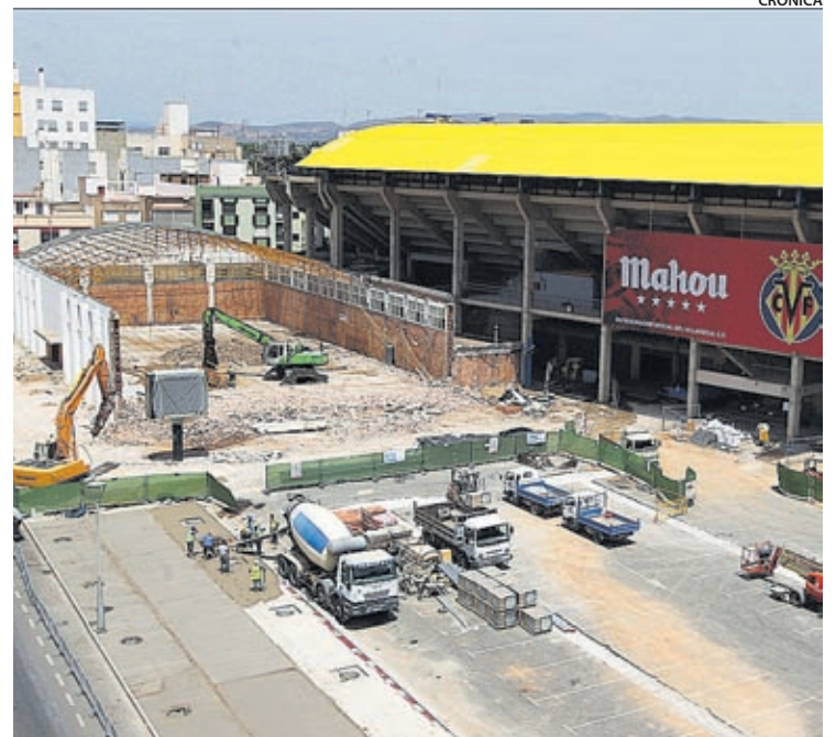
Les tasques d'enderrocament prèvies a la construcció de l'actual espai obert.
