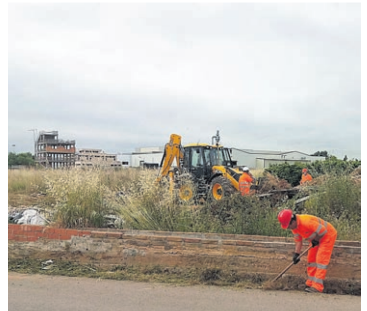
Las máquinas ya han accedido para realizar los primeros movimientos.
