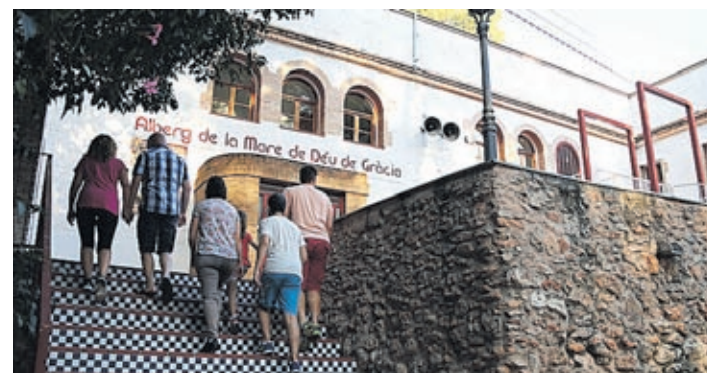
En el albergue se ha realizado una primera actuación de refuerzo.
