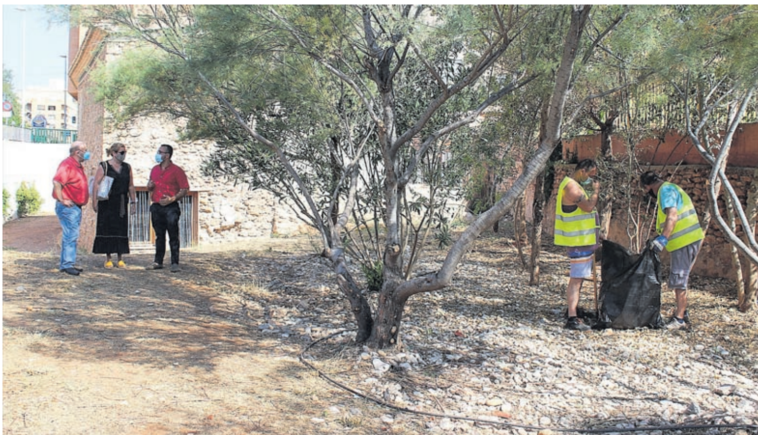
Els operaris han treballat en l'entorn del molí de la Vila per a millorar-ne la salubritat i el manteniment a l'espera d'una nova fase de rehabilitació de l'immoble.
