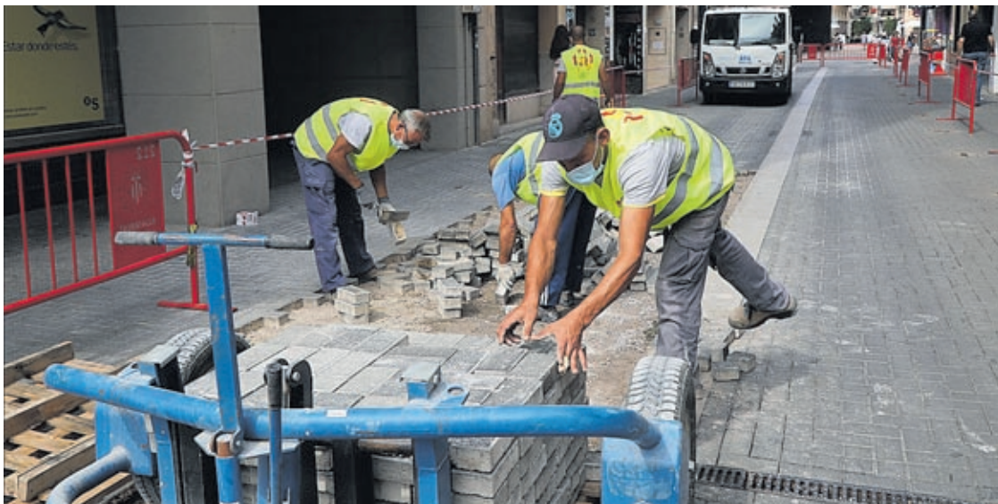
El termini d'execució de les obres, a càrrec d'una empresa local, serà d'un mes i permetrà guanyar en seguretat.
