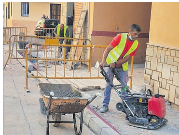
Els operaris durant els treballs de renovació de la xarxa a Furs de València.
