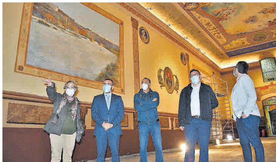
Las pinturas presentaban un fuerte deterioro a causa de filtraciones y humedades.
