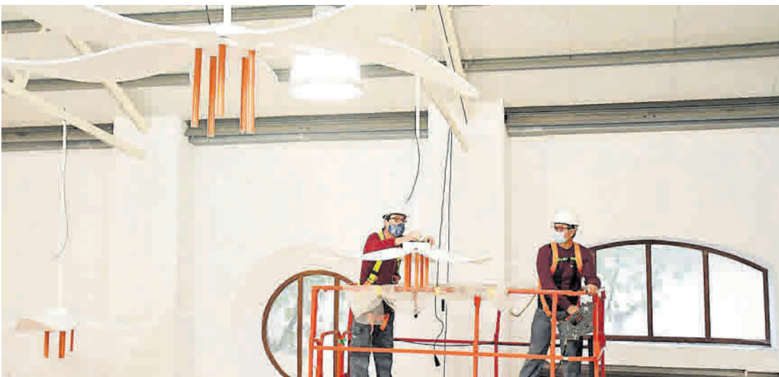
Los operarios durante el proceso de instalación de las flores que evocan a las de los naranjos.
