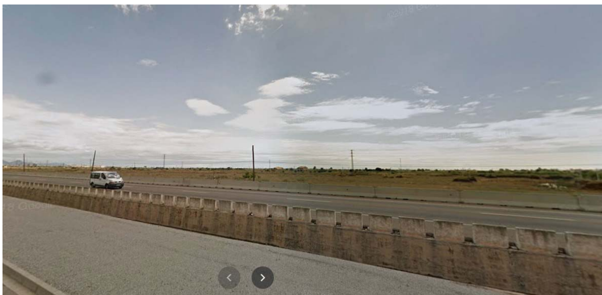
Foto 3: vista desde el otro lado de la carretera N-340, hacia el Este.
