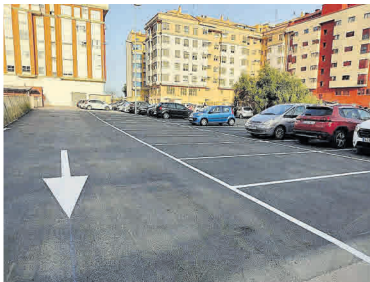
Tras el reasfaltado, se ha habilitado un espacio para estacionar coches y motos.
