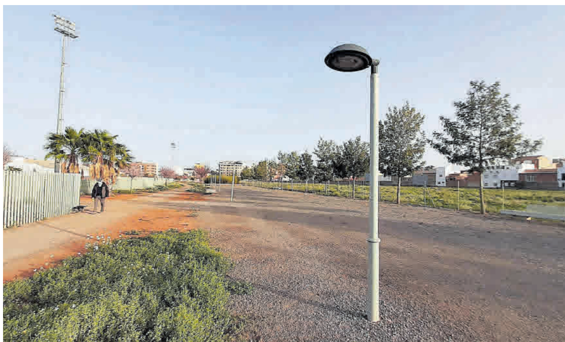
Reparar los daños en el jardín requerirá un desembolso de algo más de 500 euros para las arcas municipales.
