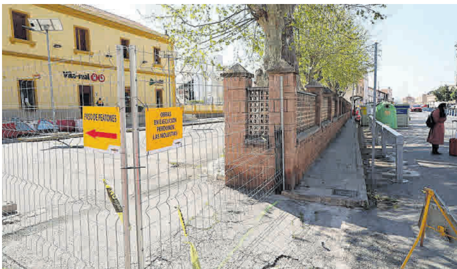
Las obras en el exterior de la estación comenzaron a finales de marzo con un plazo de tres meses.
