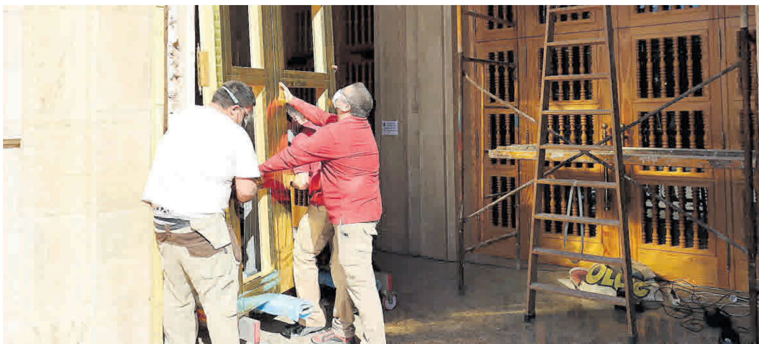
Un grupo de operarios durante las labores de sustitución del antiguo portón por la nueva puerta de acceso que da más prestancia a la entrada oeste de la basílica.
