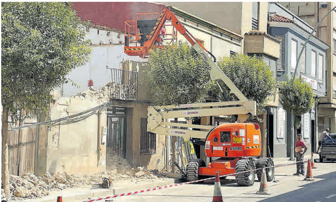
Les tasques de demolició, amb un termini aproximat de dues setmanes, van començar a mitjan mes de juliol.
