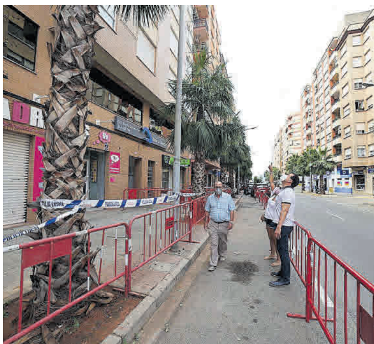
Los daños en un inmueble de la avenida Pío XII llevaron a vallar la acera.
