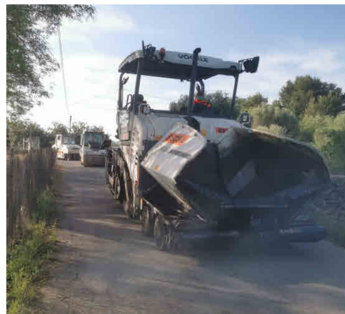
Las máquinas trabajan en el asfaltado de la partida Madrigal.
