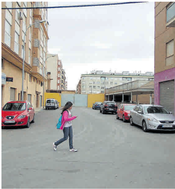
La demolición del muro permitirá abrir dos calles y un lateral de la acequia.
