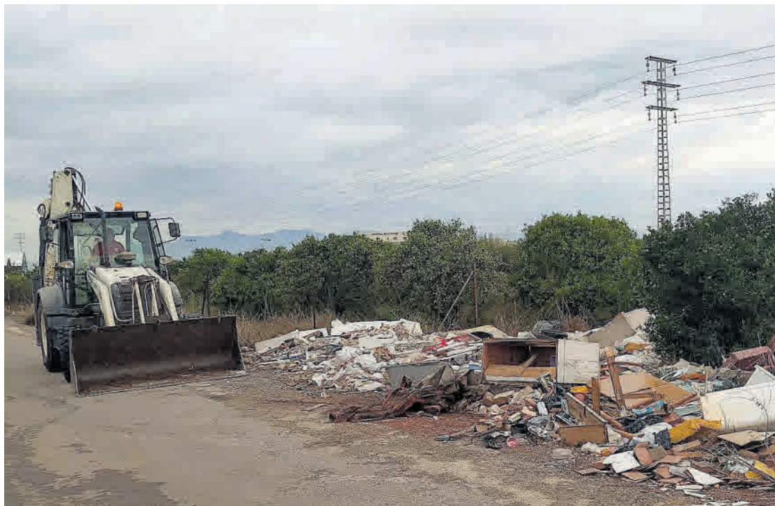
Excavadoras y camiones en el proceso de retirada de restos en uno de los seis puntos detectados y acondicionados.
