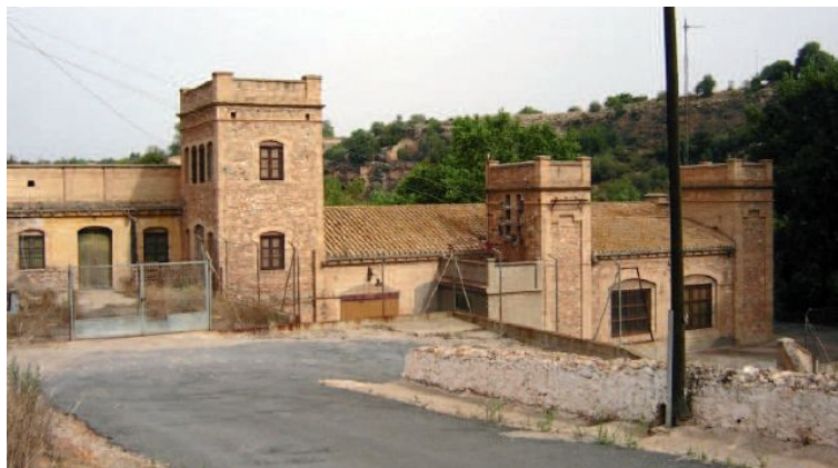
La Llum de Tol, central Eléctrico Textil. (Fuente: Chumillas, A. Análisis histórico, arquitectónico y constructivo de "La Llum de Tol" )
