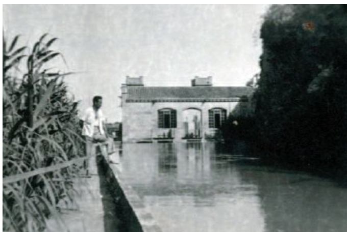
Canal de la Llum de Tol, entonces Central Eléctrico Textil (Fuente: Chumillas, A. Análisis histórico, arquitectónico y constructivo de "La Llum de Tol" )
