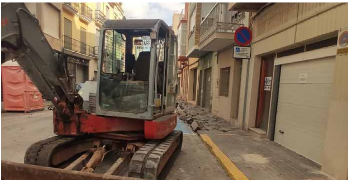
Les màquines ja treballen en la millora de la xarxa d'aigua potable que també permetrà millorar una vorera del vial.
