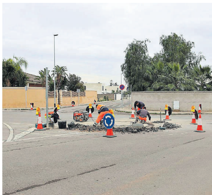
Los operarios, durante las primeras etapas de la creación de la rotonda.
