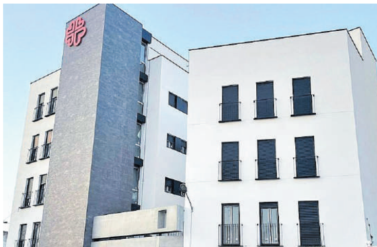
Imatge actual de l'estat de les obres a poques setmanes de la inauguració.
